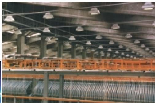
*Для промышленных цехов с очень высокими потолками: крайне редкие замены ламп благодаря рабочему ресурсу 60.000 часов.*
