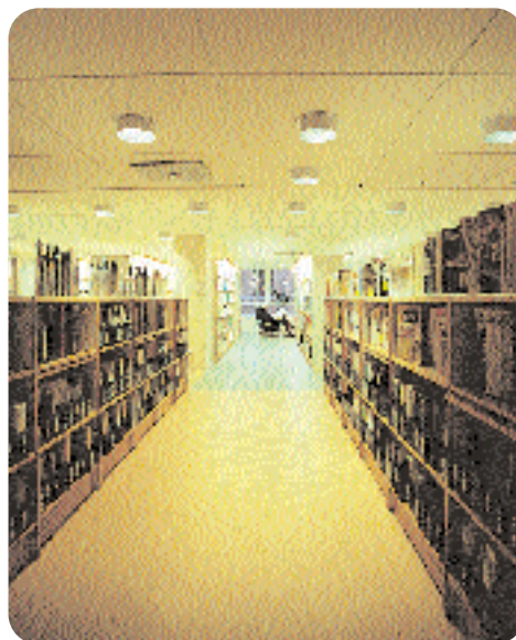
Энергосберегающие лампы Viax заменяют лампы накаливания в этой библиотеке.
