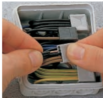
Подсоединение: зачищенный проводник вставить до упора
