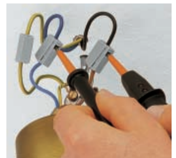
Проверка через специальное контрольное отверстие
